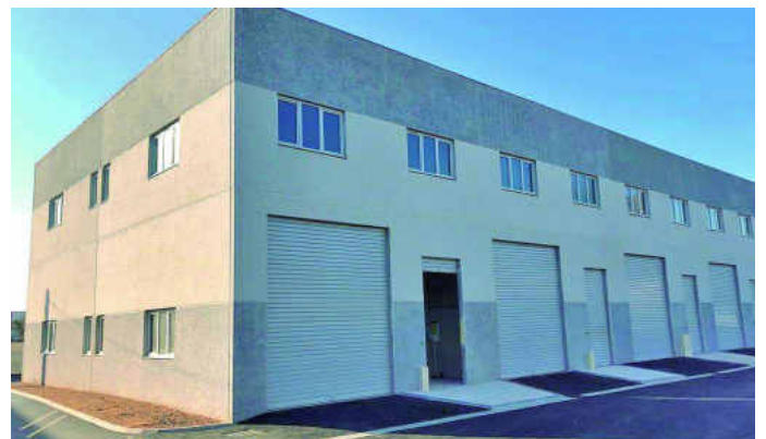
Nave prefabricada para uso industrial
