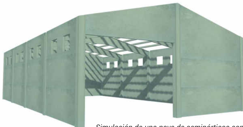
Simulación de una nave de semipórticos con todos sus elementos de cubierta y cerramiento
