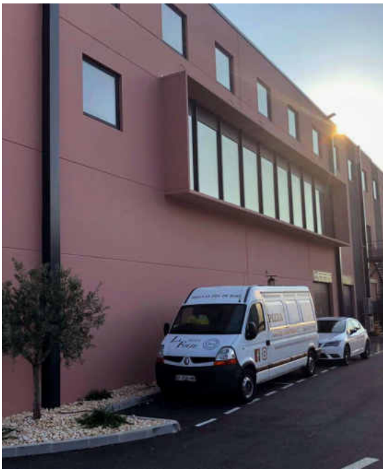
Fachada con ventana con voladizo perimetral
