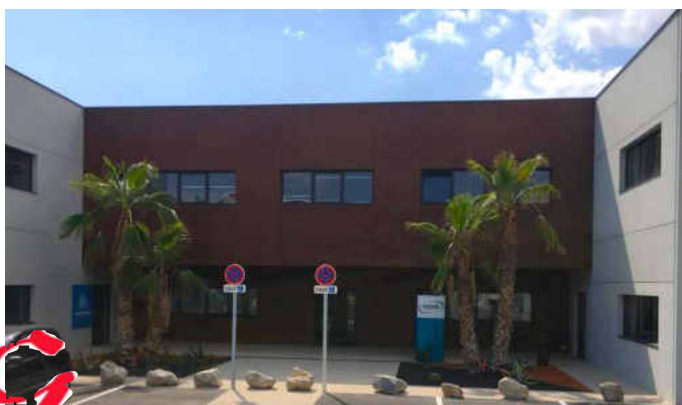
Edificio prefabricado con diferentes acabados
