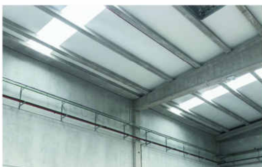
Montaje de placas cortafuegos en cubierta sobre vigas Delta en medianil de separación de dos naves preparado para colocación de canal de recogida de aguas
