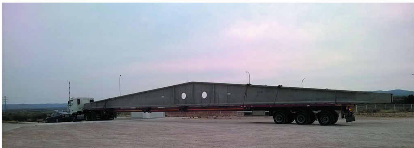
Detalle de deltas con portacanal y viga en V
