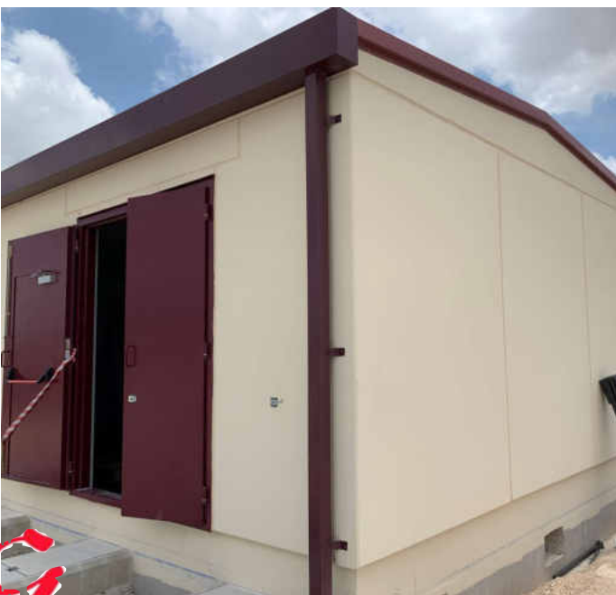
Subestación acabado exterior liso pintado
