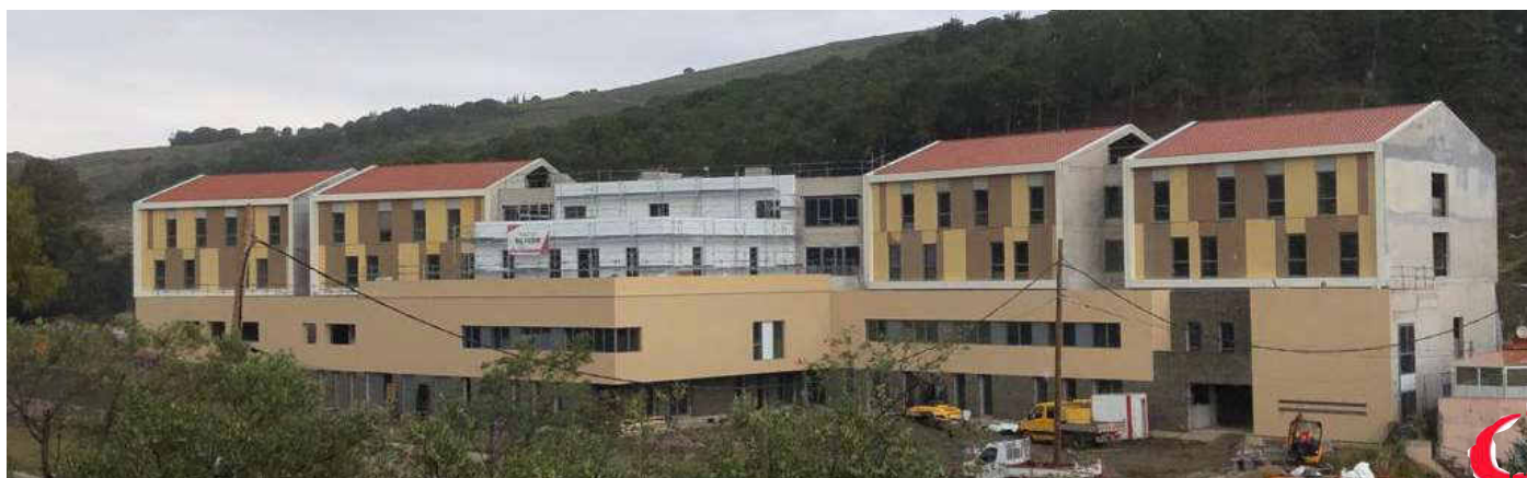
Fachada prefabricada para residencia de ancianos (Francia)
