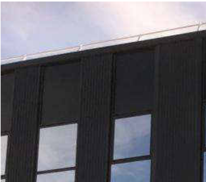
Edificio prefabricado asimétrico para almacén y oficinas con fachada metálica II (Francia)
