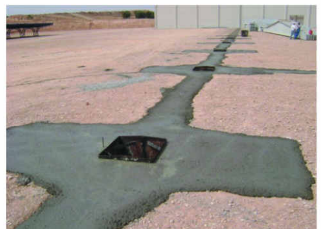
Cimentación hormigonada para pilar empotrado en cáliz
