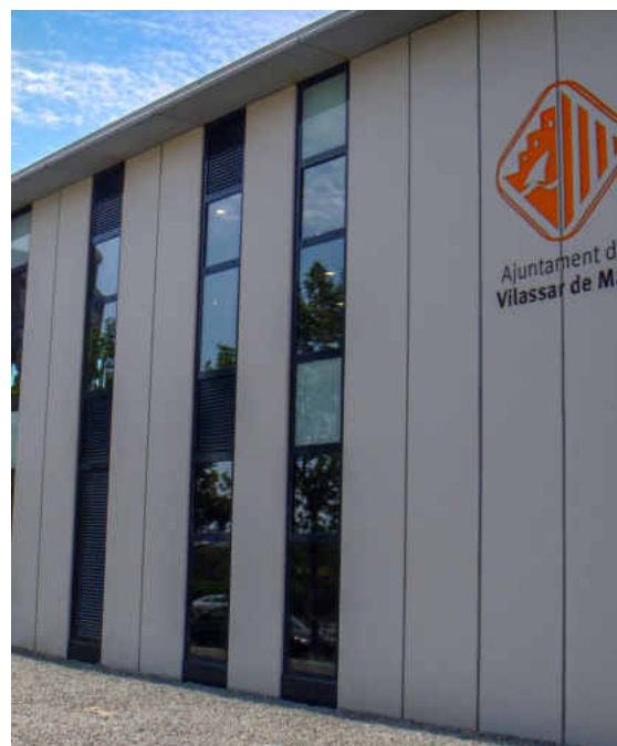
Edificio prefabricado con uso deportivo
