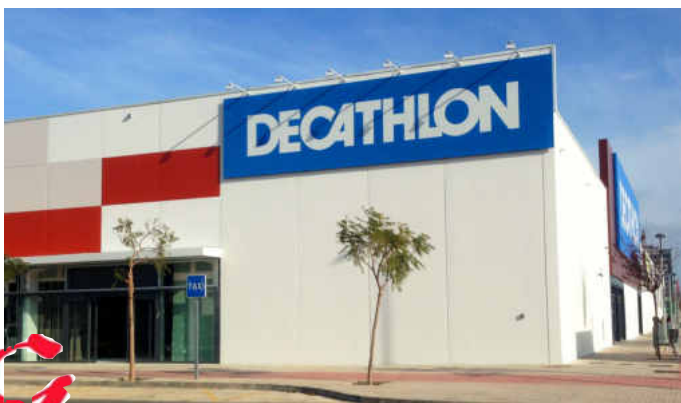
Edificio prefabricado para Decathlon
