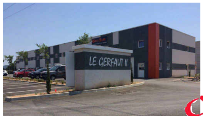
Edificio de oficinas
