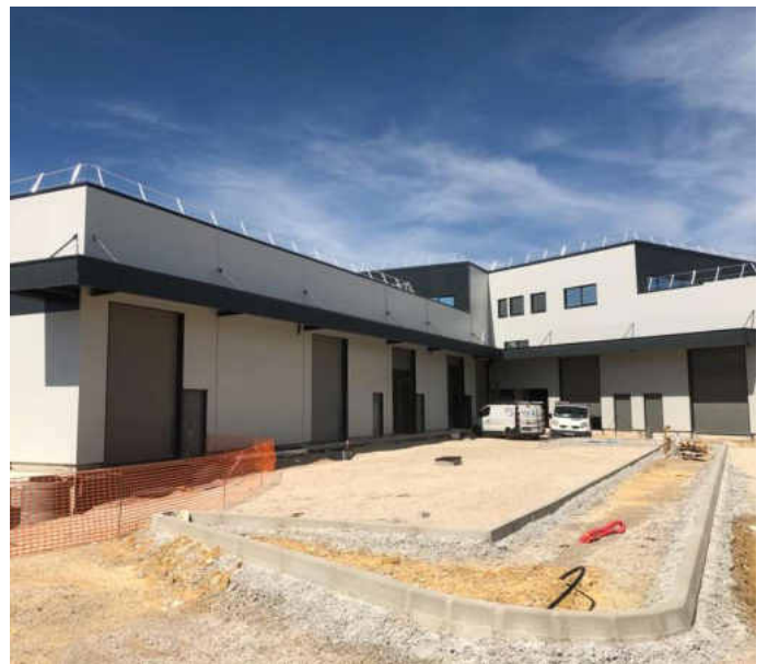
Edificio prefabricado asimétrico para almacén y oficinas con fachada metálica I (Francia)
